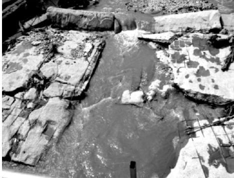
Рис. 1. Крепление русла железобетонными плитами (фото Л.З. Емузовой)
