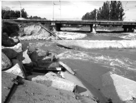
Рис. 2. Полуразрушенный донный порог (фото Л.З. Емузовой)
